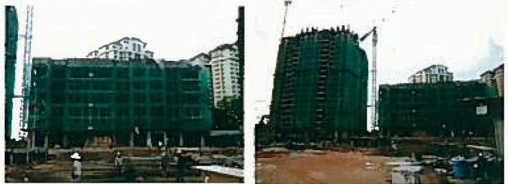
施工状況写真 (2012年5月4日撮影)
