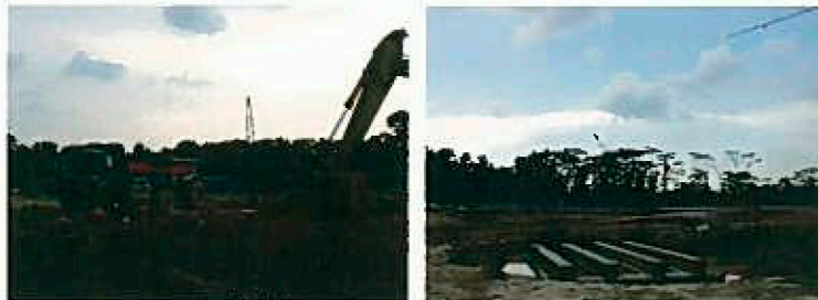
建設予定地 (2012年5月4日撮影)
